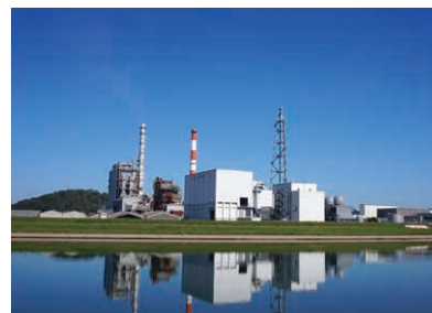
木質バイオマス発電設備 (川内工場)
