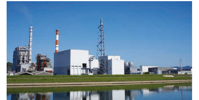
川内工場 木質バイオマス発電設備
