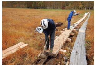
木道の架け替え工事
