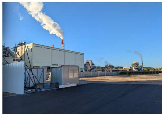
災害廃棄物仮置場用地の整備状況
