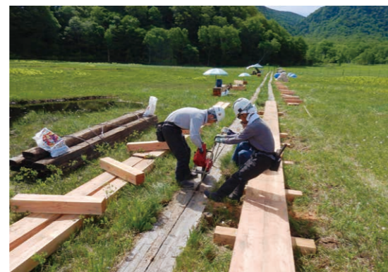
木道の架け替え工事
