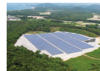
唐浜メガソーラー発電所
