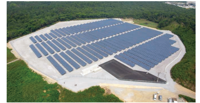
唐浜メガソーラー発電所
