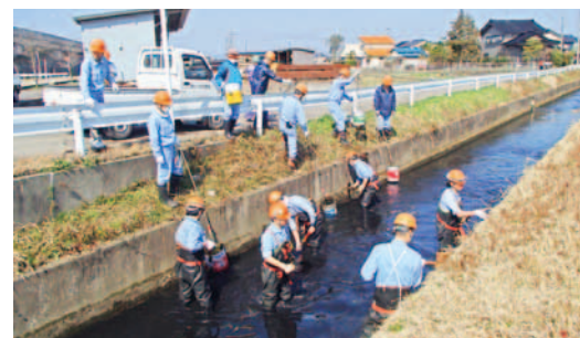
桜川清掃の様子
