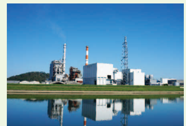
川内工場 木質ボイラ
