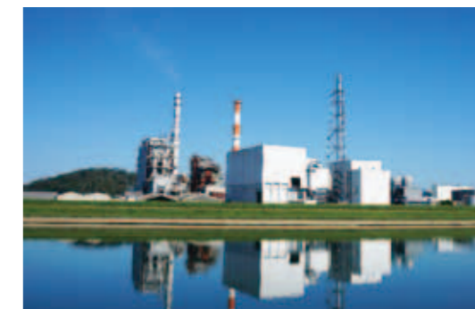
川内工場 木質ボイラー
