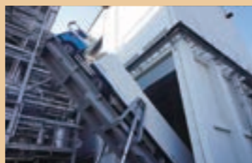
①木質バイオマス燃料の受け入れ 一日あたり約900t(トラック約40台分)の木質バイオマス燃料を受け入れます。
