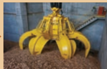
②燃料貯蔵設備 受け入れた木質バイオマス燃料は、大型クレーンでボイラ設備へ搬送します。
