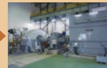
④タービン設備 ボイラで発生した蒸気を利用して、発電を行います。
