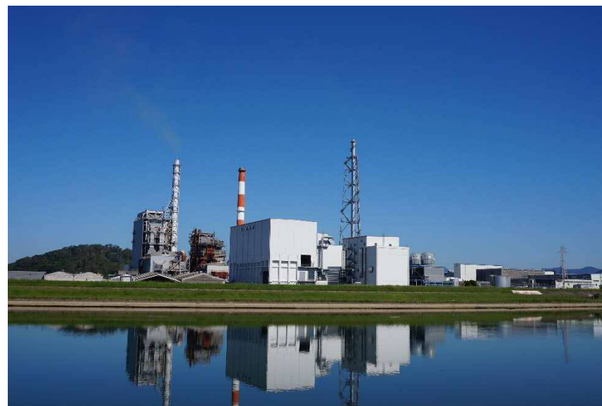
『平成27年11月稼働 バイオマス燃料発電設備』(川内工場)
