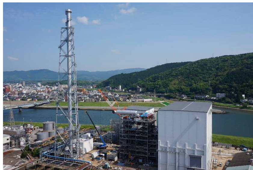
『建設中 バイオマス燃料発電設備』(川内工場)
