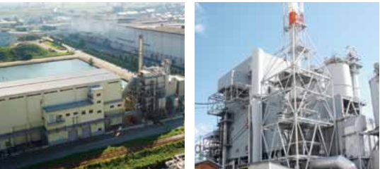
木質燃料ボイラー (高岡工場)
