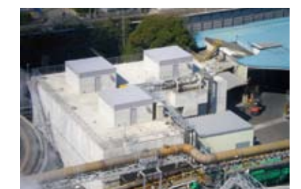
新酸素曝気設備
