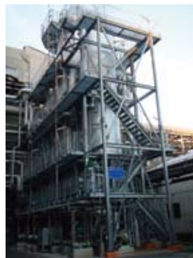
プレエバ設備（排熱回収）
