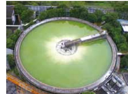
川内工場 No.2 クラリファイヤー
