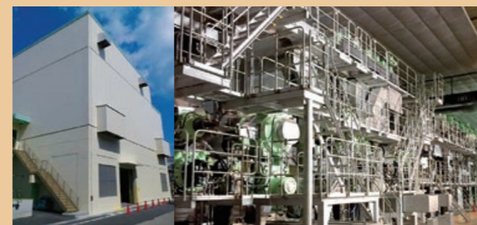
高級白板紙生産設備(建屋および抄紙機外観)
