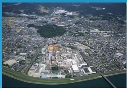
川内工場(鹿児島県薩摩川内市)
