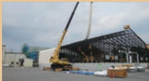
新パルプマシン 12月稼働に向け急ピッチで建設を進めています
