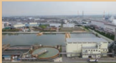
水面整理場の埋め立て工事に着工
