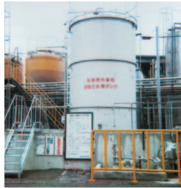
過酸化水素添加設備の設置(2000年) 次亜塩素酸ソーダから過酸化水素に変更。晒クロロホルムの排出減少。
